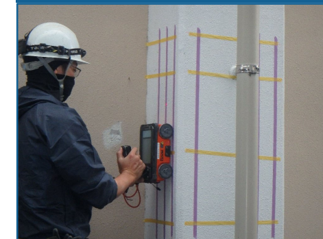
(柱の配筋調査)
