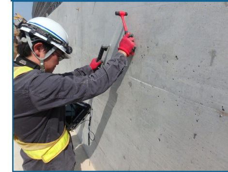
(コンクリート強度表面2点法)
